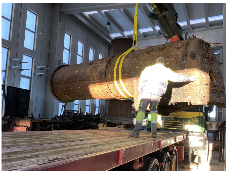
Grues posant la locomotora a damunt el
